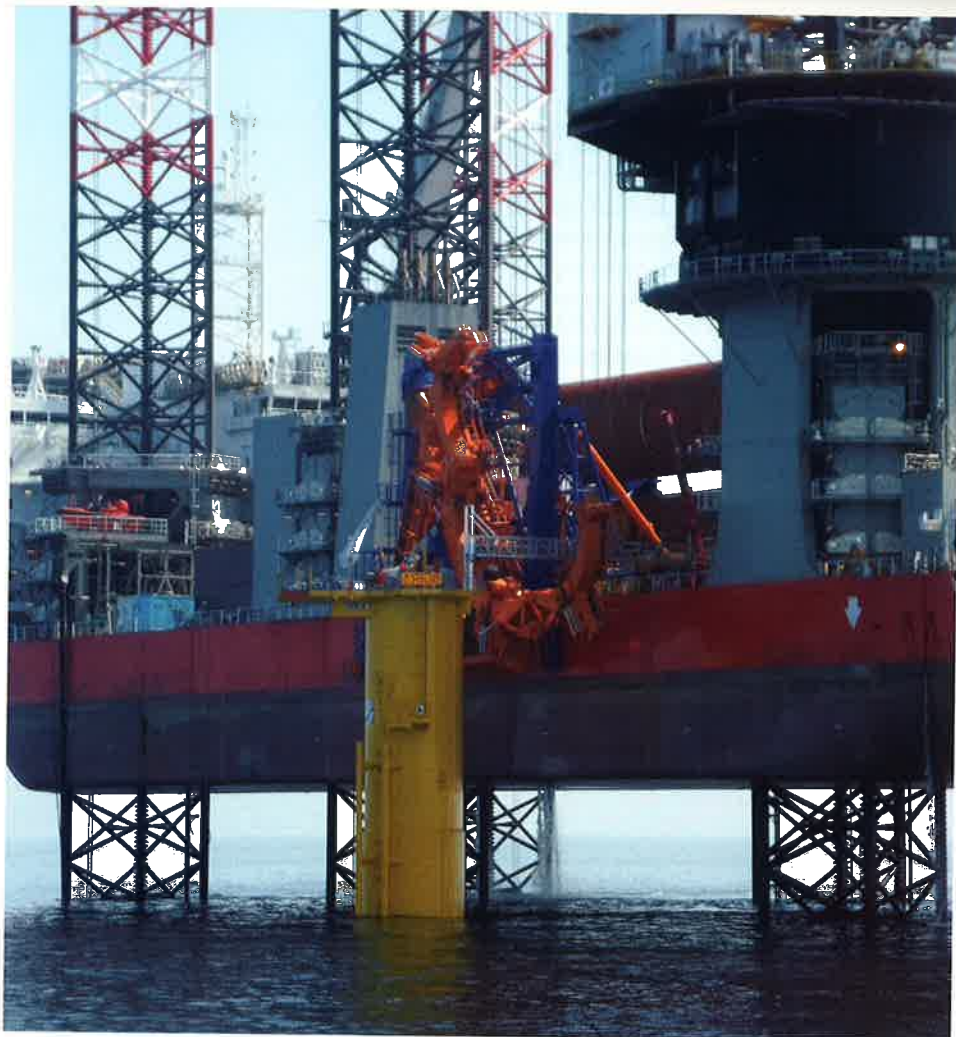
Hier is goed te zien hoe een Transition Piece (TP) op een monopile geplaatst wordt.
